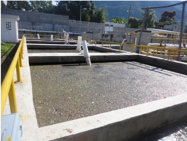
Figura No. 1 Primer sedimentador
