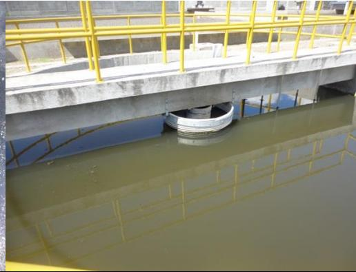
Fig. No. 1 Sedimentador Primario
