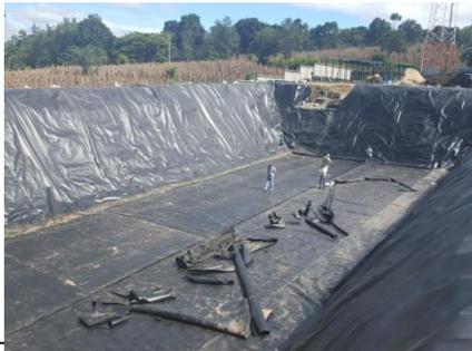
Puesta de geo membrana en la construcción del relleno sanitario en el municipio de San Pedro La Laguna
