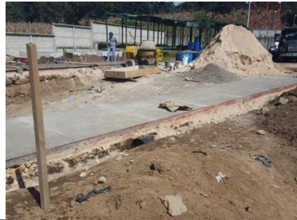
Construcción de banquetas y cunetas en el proyecto de construcción de relleno sanitario en el municipio de San Pedro La Laguna
